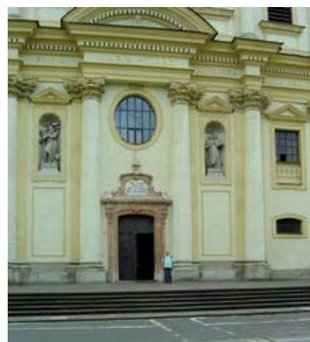
Portal Bazyliki w Szashtynie.
