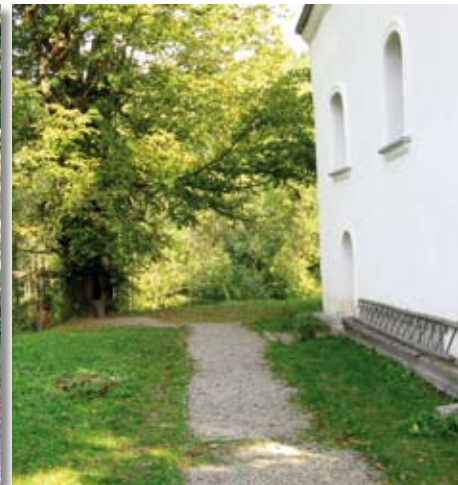
Odnowiona i otynkowana ściana cerkwi. W głębi widoczna legendarna lipa.
